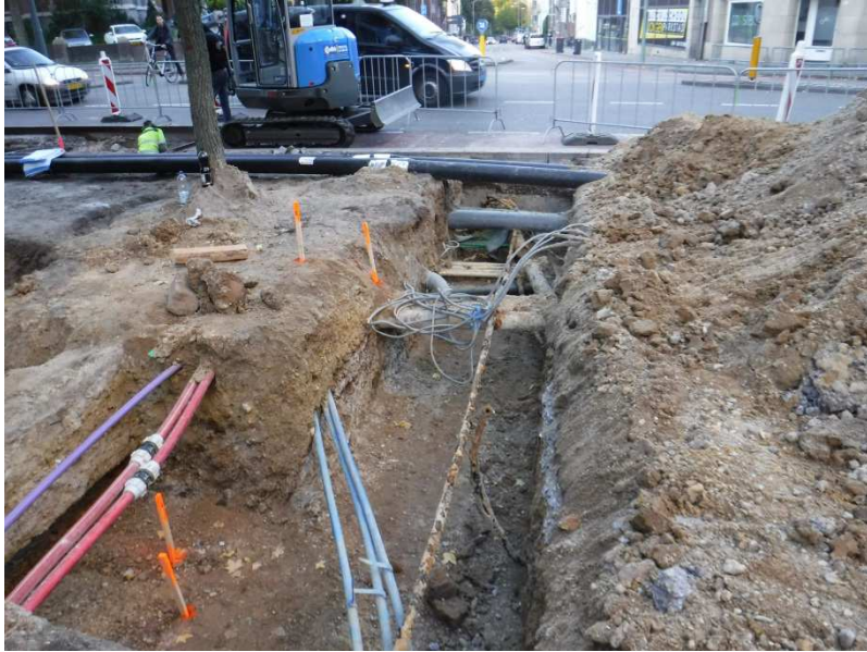
Figuur 9. Sleuf ter hoogte van hoek Geleenstraat, op 21-9-2017
