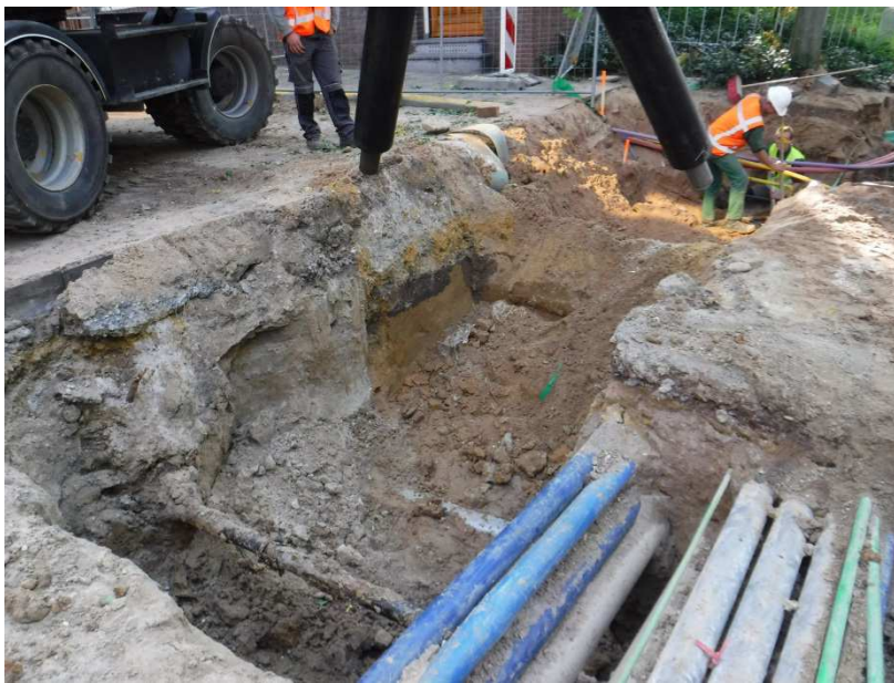
Figuur 8. Sleuf dwars over de Uilenstraat, op 22-9-2017
