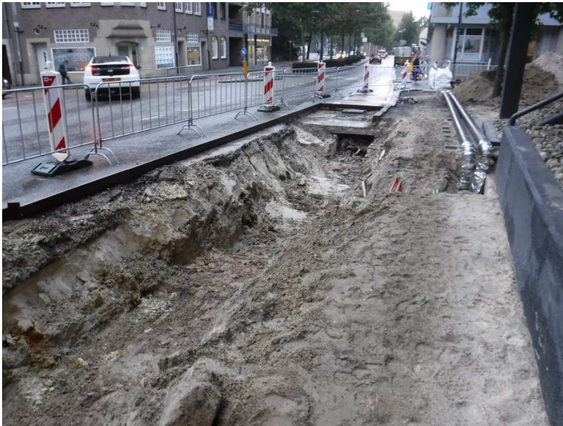
Figuur 7. Sleuf tussen Geleenstraat en Uilenstraat, op 18-9-2017
